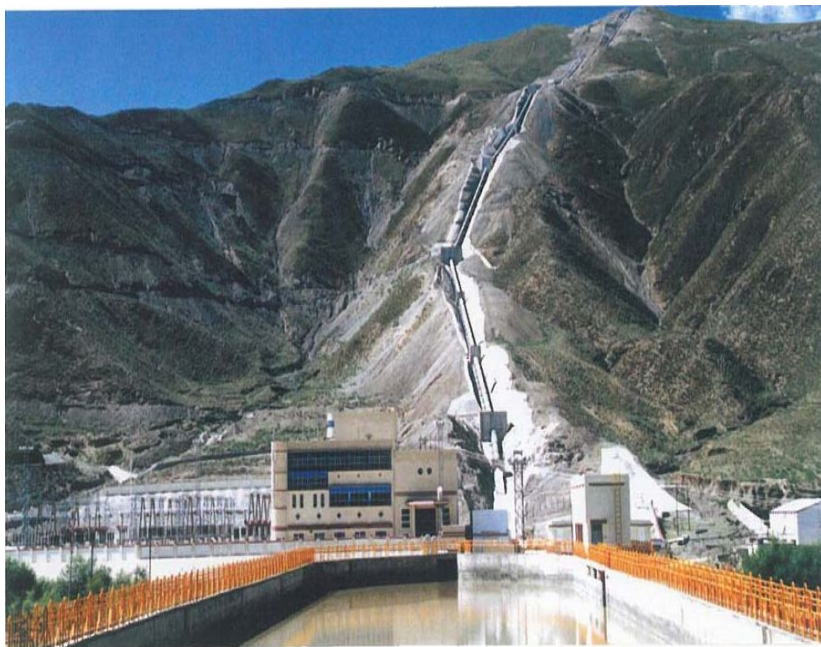
图二：羊卓雍错水电站
